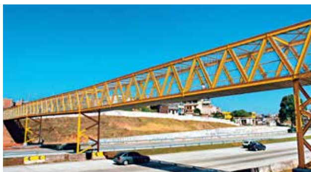
Foto Gerda Açominas – Rodoanel - Passarelas construídas com vigas isostáticas treliçadas e piso executado com lajes estruturais tipo steel deck
