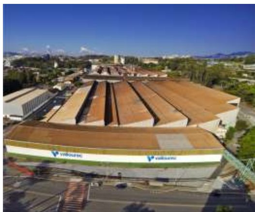
Usina da Vallourec em Belo Horizonte (MG)
